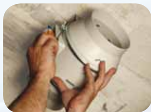
Colocar o corpo motor
