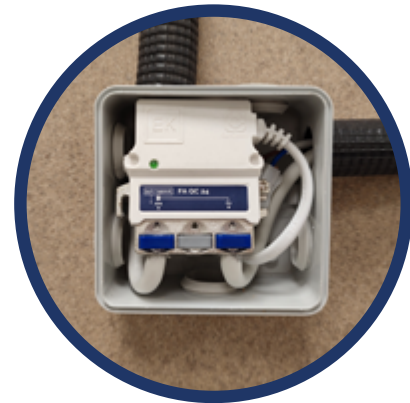
Instalação em caixa de 80 x 80mm
